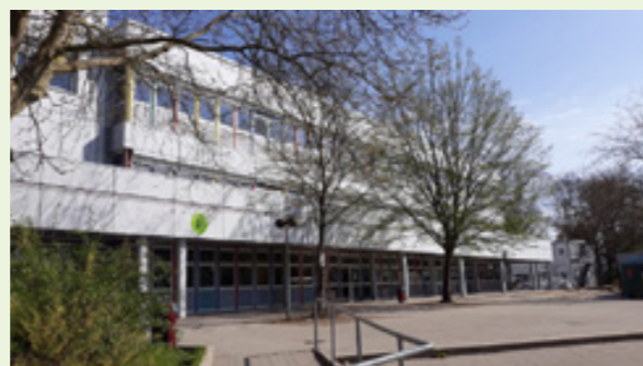
Das Fachhaus vor der Sanierung und heute
