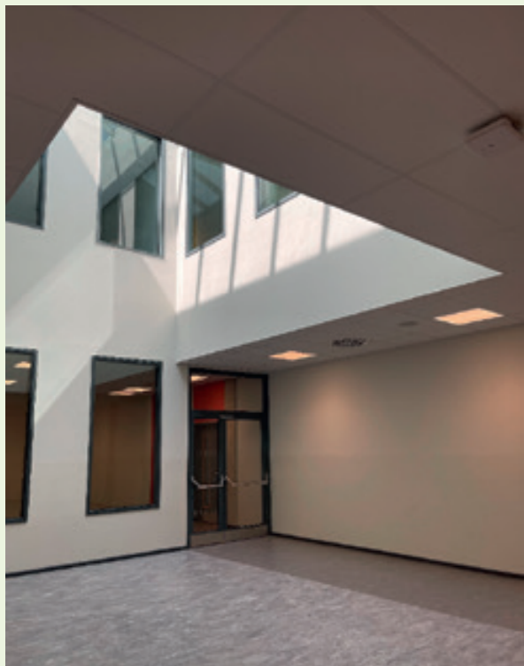
Blick ins sanierte Fachhaus
