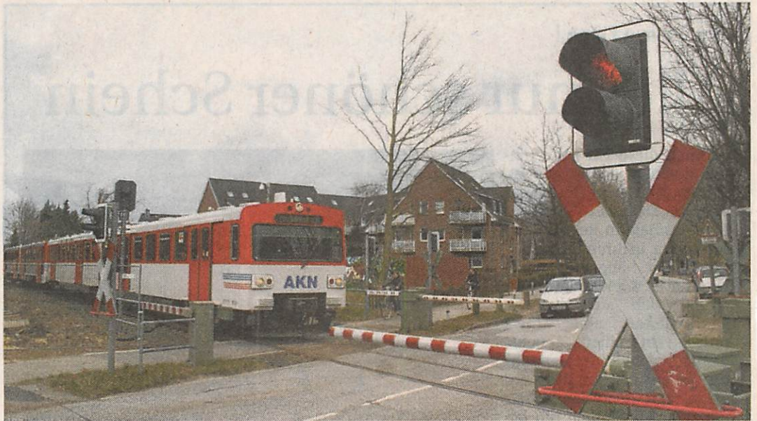
Die neue Haltestelle „Schnelsen Süd“ soll hier an der Halstenbeker Straße entstehen
